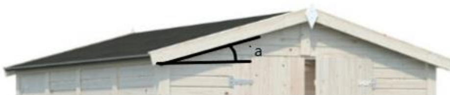
Joonis 1. Katuse kaldenurga mõõtmine.
