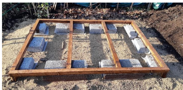
Joonis 3. Lisaks plokkidele võib kuuri põhja kinnitada maasse löödud vaiadele.
